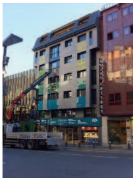
Foto 1. Façana principal durant la reforma
