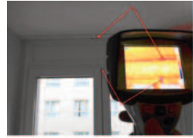
Foto 11. Localització de les infiltracions d'aire per les noves finestres durant l'assaig "Blower Door"
